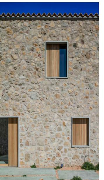
Principe d'encadrement des ouvertures en enduit à la chaux
