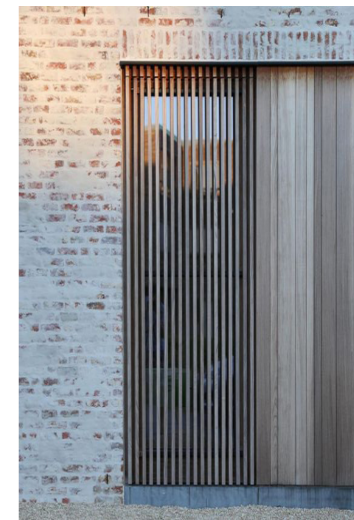
Principe de bardage avec des clins en bois
