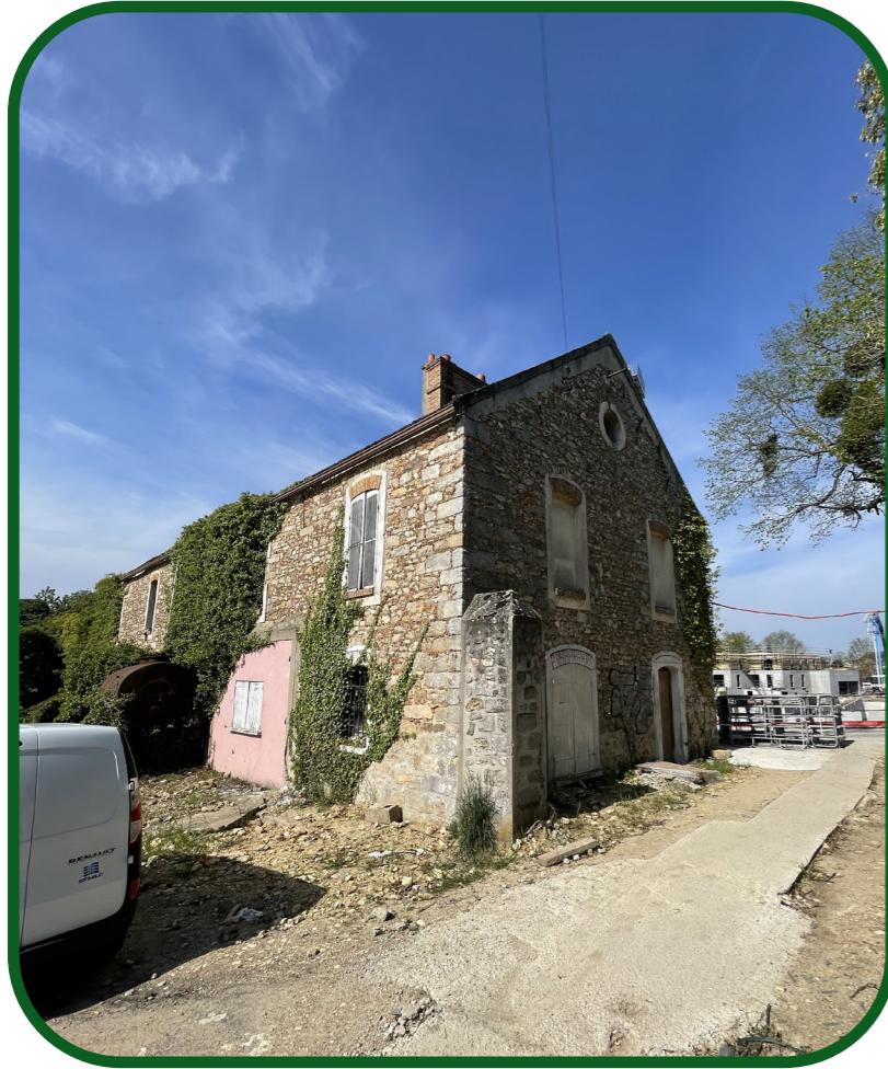
bâtiment réhabilité en local d'activités
