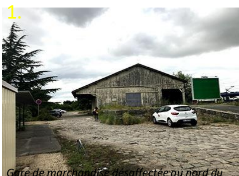
Gare de marchandise désaffectée au nord du bâtiment voyageur.
