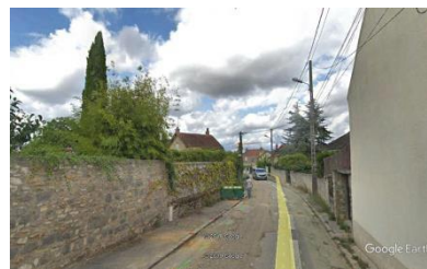
Mur de clôture rue du Gros Caillou
